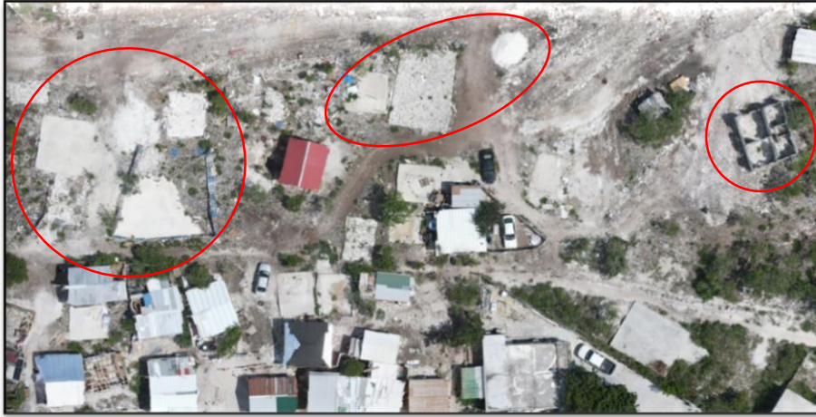
Figure 3 Dock Yard - Prèw Konstriksyon yo kontinye
